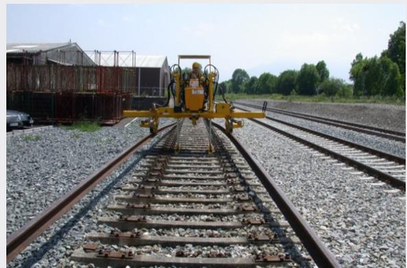
Kontinuierliches, schrittweises Versetzen von Schienen auf die gewünschte Spurweite mit ROTHREAD
