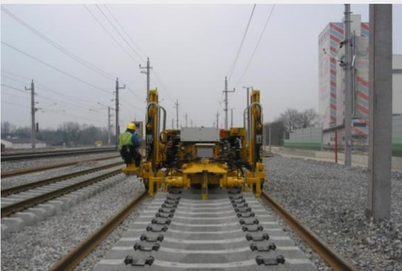
Schwellen akkurat und abtandsgleich verlegen, bereit zur Schieneninstallation
