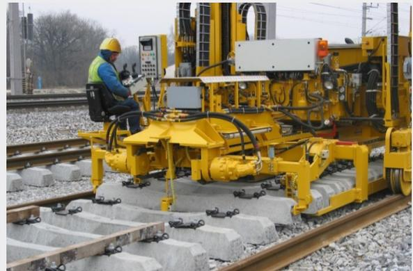
Millimetergenaues Verlegen der Schwellen - ca. 5 sek./Schwelle
