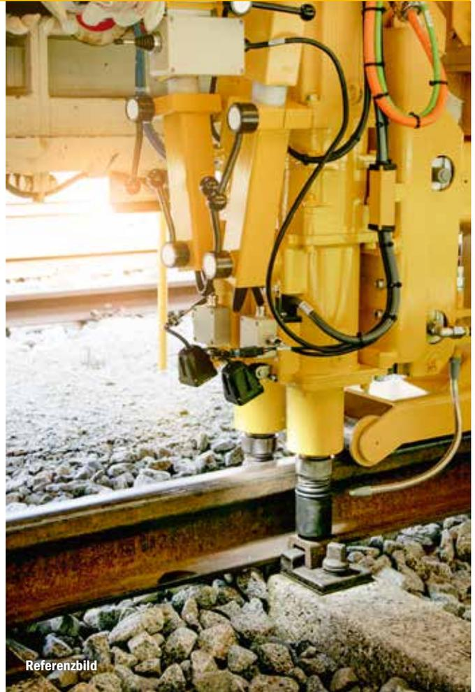
**Zum synchronen Anziehen oder Lösen aller im Gleisbau anfallenden Schraubarbeiten innerhalb ROMIS Mobilen Instandhaltungseinheit von ROBEL.**
